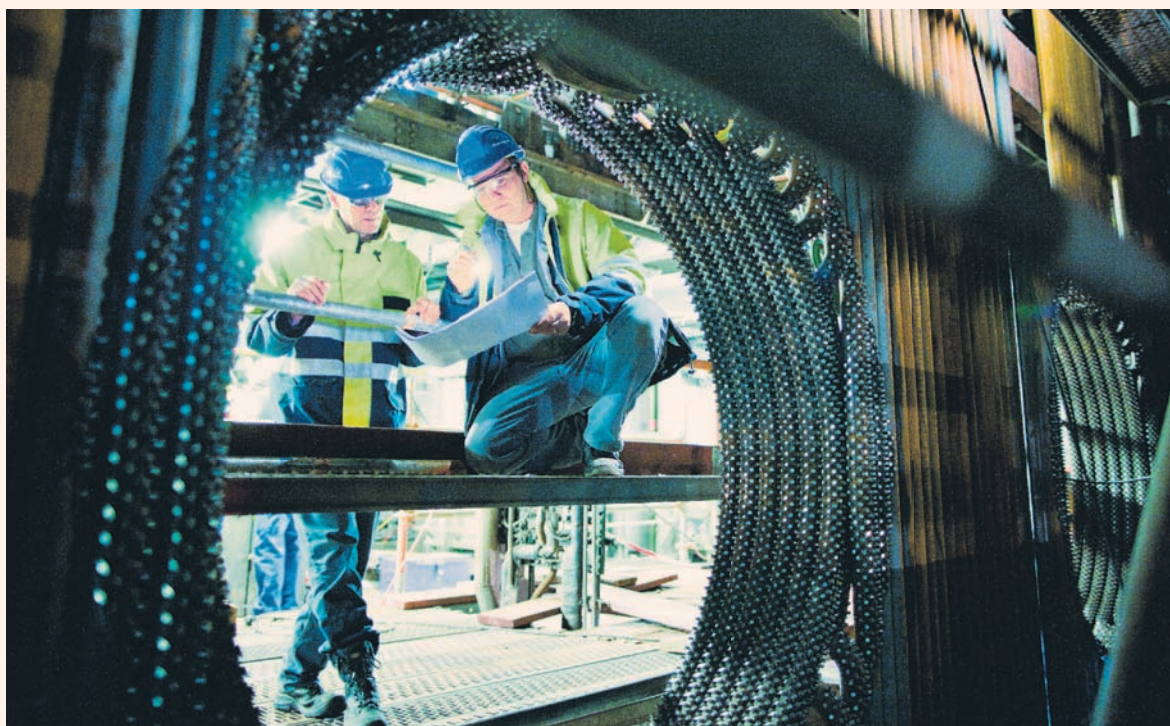
Prüfung nach dem Vieraugen-Prinzip: Ausbiegung für Gichtgasbrenner (Fotos: BBPS)
