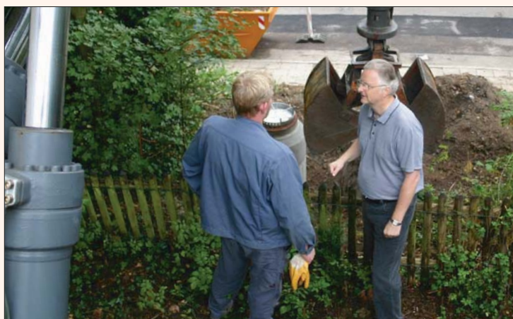
Friedhelm Tillmanns begutachtet mit einem Mitarbeiter eine Baustelle in Essen (Foto: Beenen)
