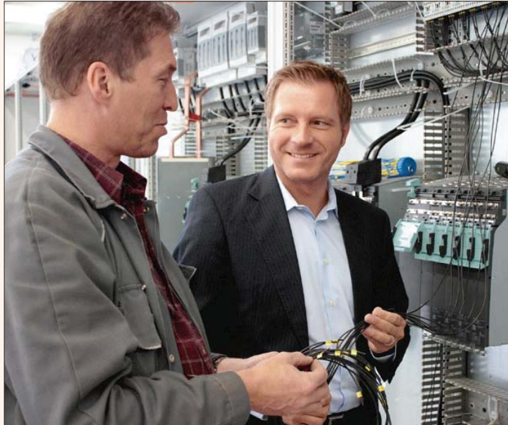
Thomas Lebbing (rechts) bespricht mit einem Mitarbeiter eine Schaltanlage, die in China eine Maschine steuern wird, auf der Lack auf Hochglanz-Möbelfolie aufgebracht wird (Foto: Beenen)
