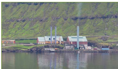
Bild links: Sund Motorenkraftwerk
