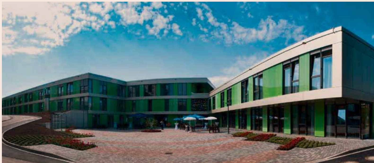
Das für 13,6 Mio. Euro neu erbaute „Zentrum für seelische Gesundheit“ in Groß-Umstadt (Foto: Kreiskliniken)
