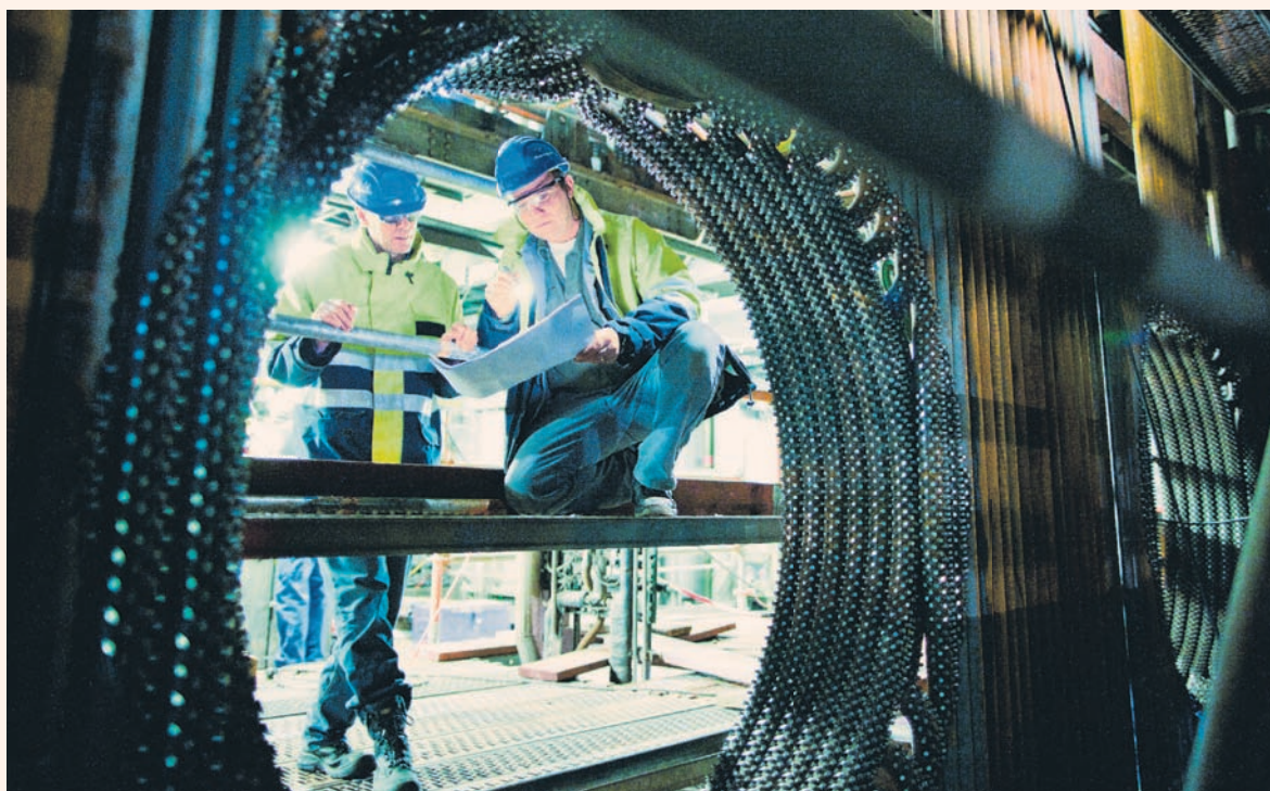
Prüfung nach dem Vieraugen-Prinzip: Ausbiegung für Gichtgasbrenner (Fotos: BBPS)
