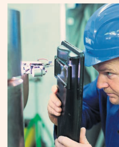
Qualität im Blick: Fortschritt an der Orbitalschweißanlage
